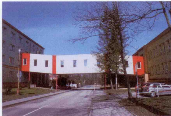
Zateplení spojovacího koridoru
